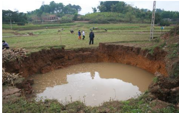
Hồ chứa nước không có biển cảnh báo, không có rào chắn, không lấp sau khi sử dụng
