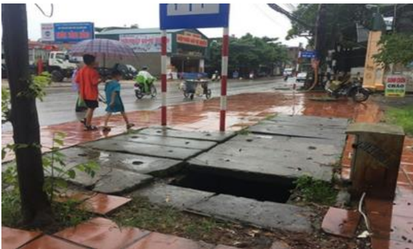
Cống thoát nước công cộng không có nắp đậy, hồ chôn cột điện không lấp
